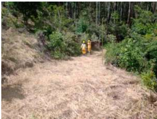
Foto 1 – Atividade de alinhamento e marcação (registro fotográfico 13/01/2022).
