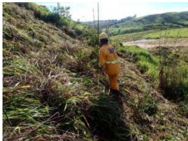
Foto 18 – Equipe realizando manutenção em campo (11/01/2022).
